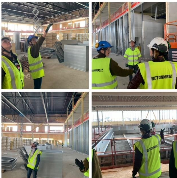
Fra befaring nye Fjellhamar skole; hall og basseng
